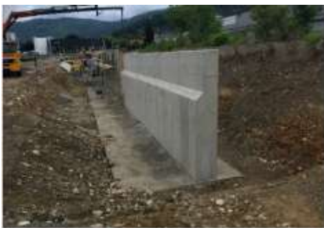
Schalungsarbeiten Stützmauer bei der Endhaltestelle
