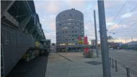
Stadionplatz Blickrichtung Westen
