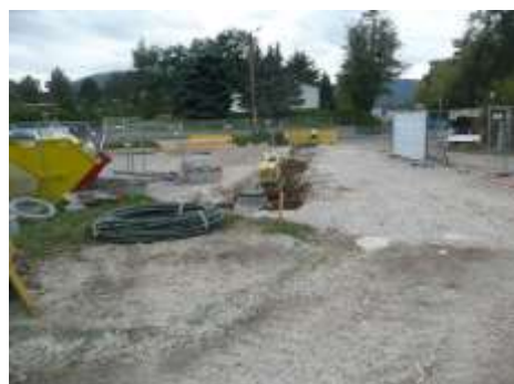
Anschlussarbeiten des Schmutzwasserkanals
