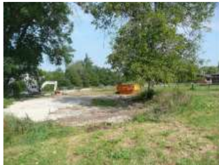
Abbruch/Entsorgung von Altfundamenten; Rodungsarbeiten
