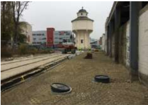
Herstellen der ungebundenen Tragschicht in der Daungasse
