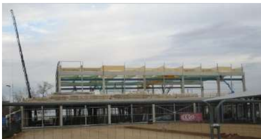
Baufeld Südost Halle: Fassade und Dachdeckung in Arbeit
