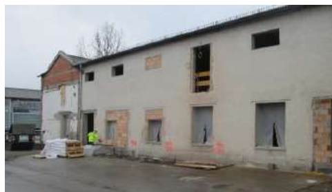
Objekt 15 Umbau und Sanierung in Arbeit
