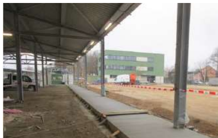
Baufeld Südost Flugdächer aufgestellt
