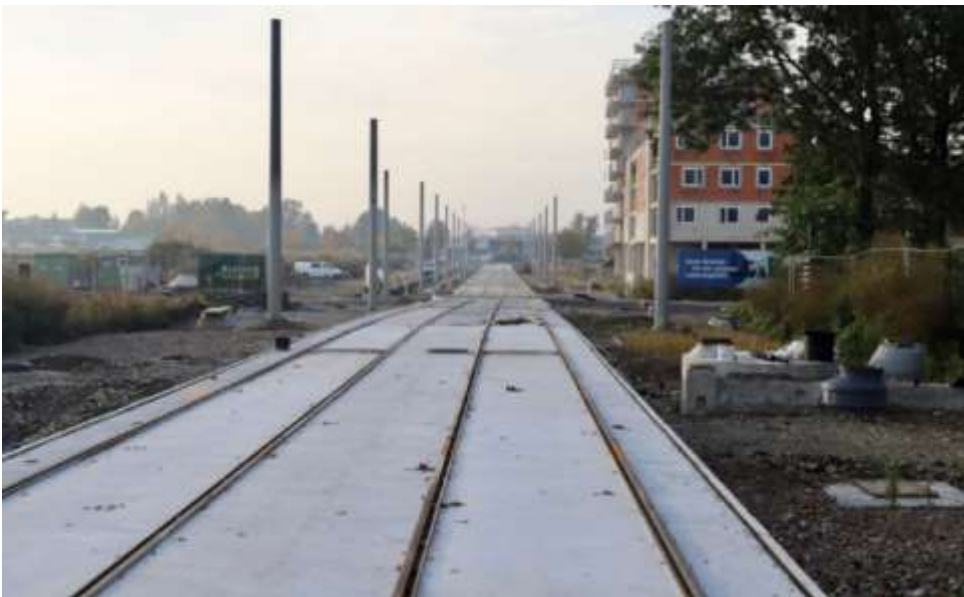
Gleistrasse Baufeld 4b (UNESCO-Esplanade südlicher Bereich)
