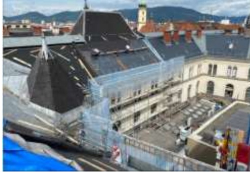
Dachsanierung Blickrichtung Innenhof
