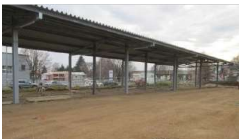
Baufeld Südwest Flugdächer aufgestellt
