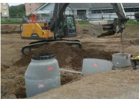
Versetzen von Spülschächten der Versickerungsanlage
