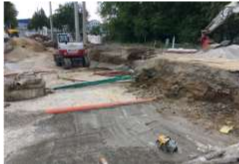
Abtragsarbeiten in der Asperngasse
