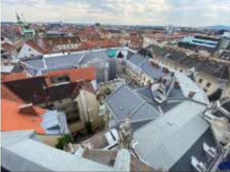
Dachsanierung Blickrichtung Schmiedgasse/Landhausgasse
