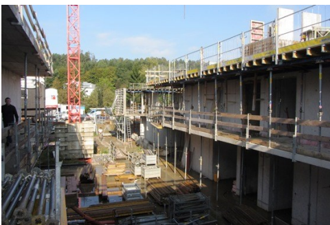
Außenansicht (Fotos StRH)
