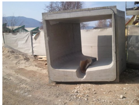
Speicherkanalprofil ehem. Schleppbahntrasse
