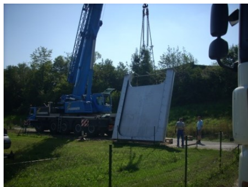
Absperrschütz, Vorbereitungen zum Transport und Einbau
