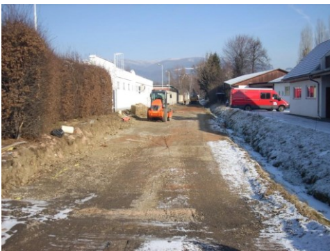
Kanaltrasse ehem. Schleppbahntrasse Bauphase
