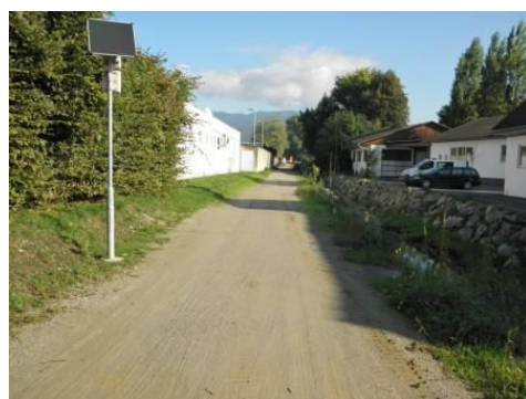
Kanaltrasse ehem. Schleppbahntrasse fertig gestellt
