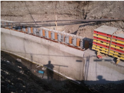
Zulauf HSEK - Kläranlage
