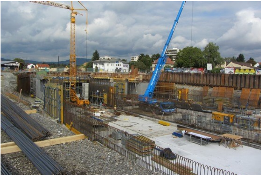
Baustelle Südguertel; Foto StRH
