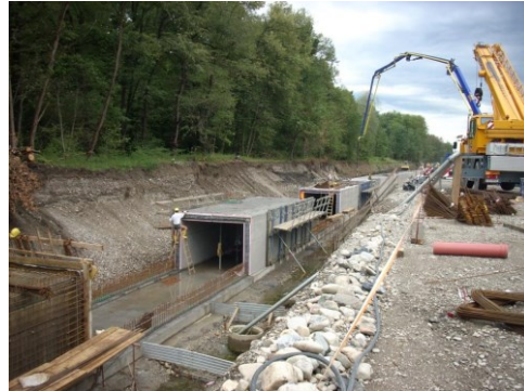
Ortbetonabschnitte HSEK
