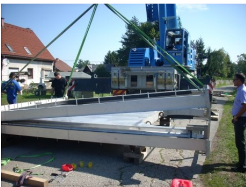
Absperrschütz, Vorbereitungen zum Transport und Einbau
