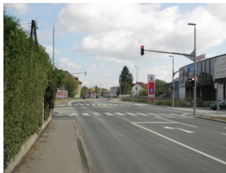
Peter-Rosegger-Straße, neu errichtete Kreuzung, Blickrichtung Osten
