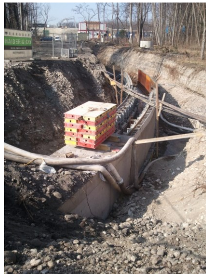
Zulauf HSEK – Kläranlage
