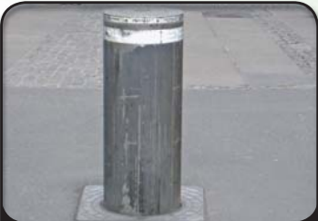
SAURAUASSE Klar erkennbare Zufahrtsregelung durch versenkbaren „Poller“.
