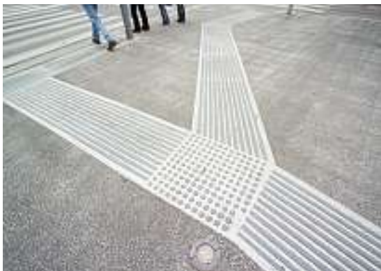
Bodenleitsystem für Blinde und Sehbehinderte: Querrillen befinden sich vor Zebrastreifen, Leitlinien weisen den Weg.
